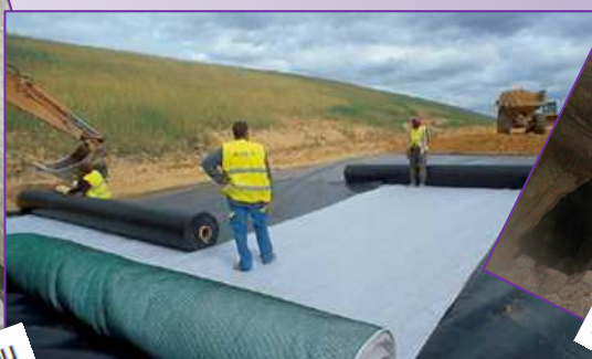
Mise en place d'un géosynthétique
